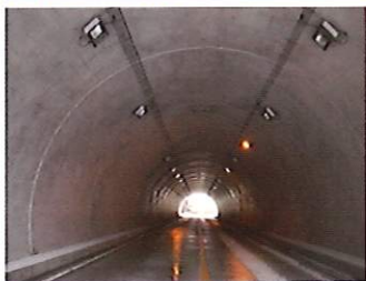
トンネル覆工
